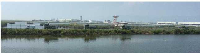
工事車両が次々と目の前を歩いていきます。
